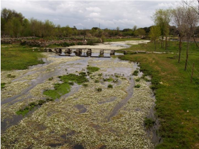
Fariza (Za), puente romano.
